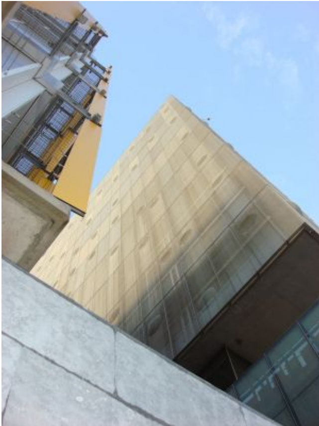
Indra Fassade mit Architekturgewebe
