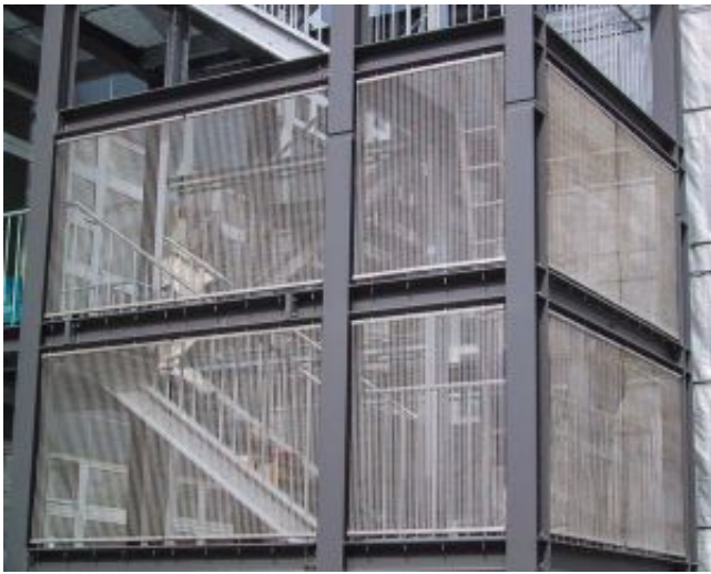
Treppenturm mit Metallgewebe
